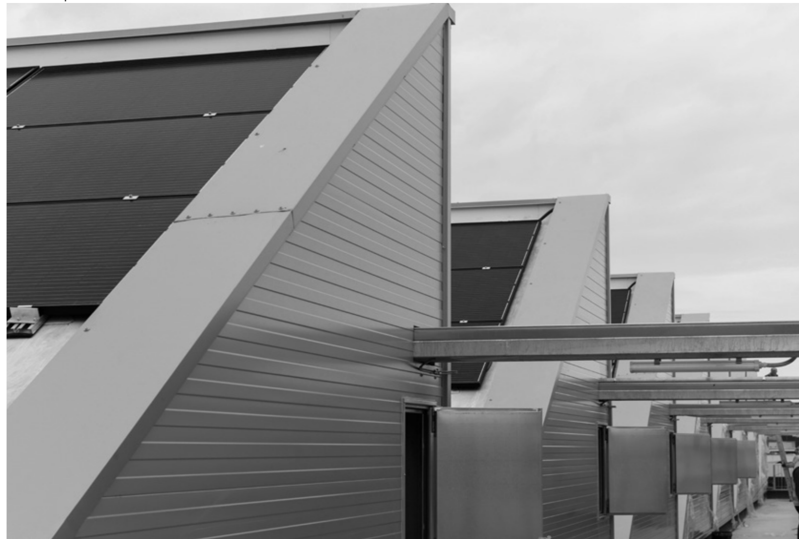
Instalación de placas fotovoltaicas en el mercado bio.
